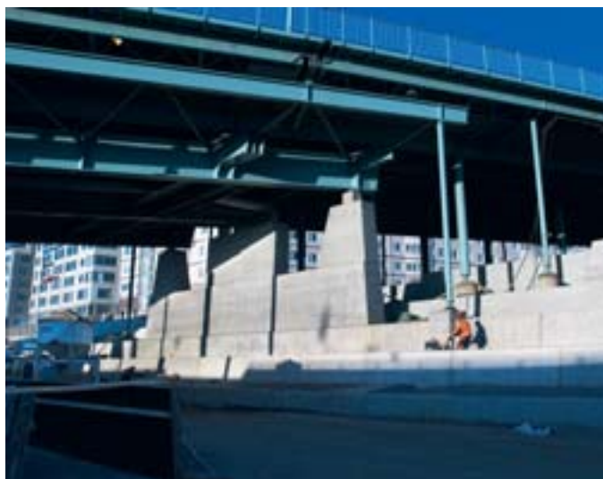
Götaälvbron har fått högre stöd och nya balkar där Götaleden passerar. Betongterrasserna kommer att prydas av växter (vår 2005).
