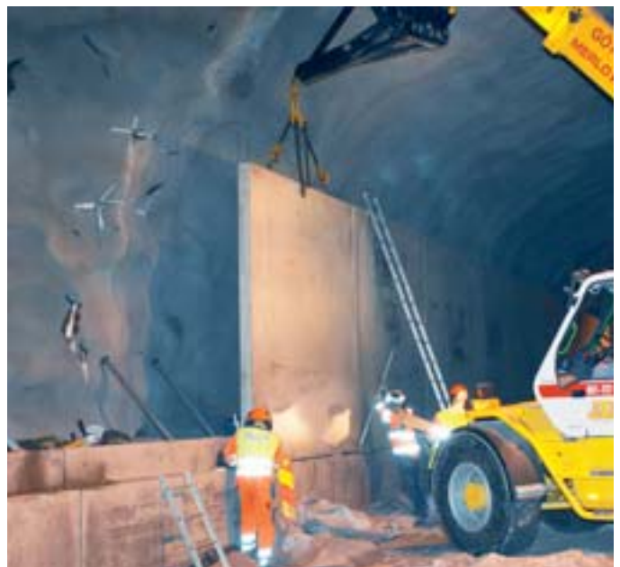
Väggelement monteras i bergtunneln. På dessa ska sedan 24 000 m 2 vitt kakel appliceras (höst 2004).
