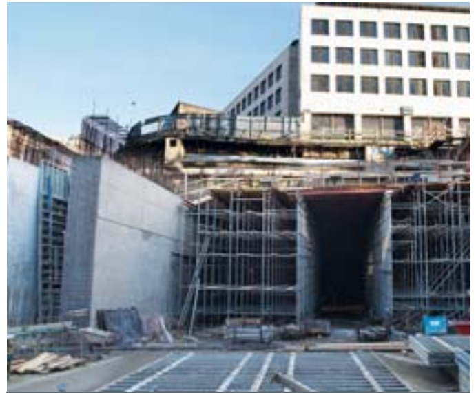
30 meter in under Rosenlundshuset slutar betongtunneln och övergår i bergtunneln. En del av huset vilar på tunneltaket (höst 2004).
