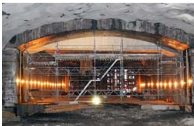
Bergtunneln möter betongtunneln under Torggatans mynning vid Lilla Bommen (höst 2004).
