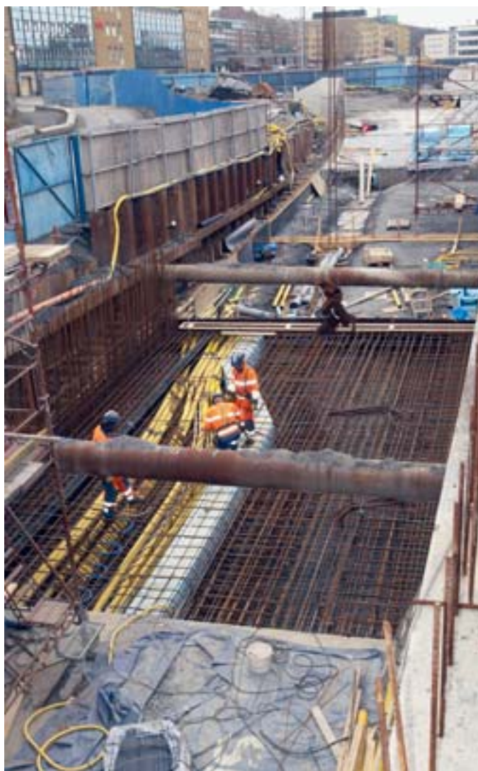
Sommaren 2005 färdigställs på- och avfarter vid det blivande Järntorgsmotet (vår 2005).
