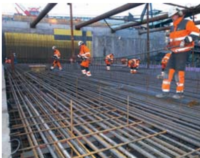
Omfattande armeringsarbeten vid Lilla Bommen. Tunnelns botten är ca 1,5 meter tjock (vår 2005).
