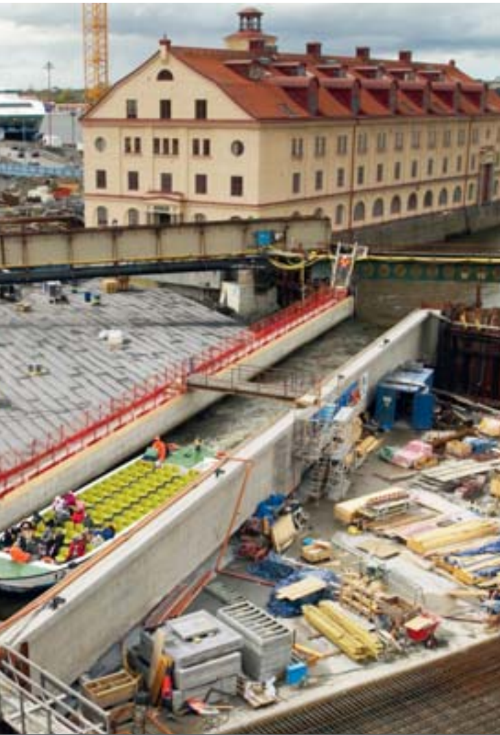
akvedukten. Efter årets säsong rivs akvedukten – som är landets vilas då på tunnelns tak (vår 2005).
